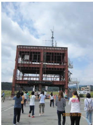
避難を呼びかけた女性職員が犠牲になった防災センター
